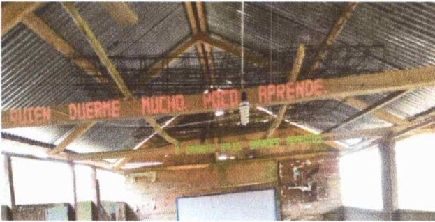
Foto 3: se observa estructura de madera en mal estado de las aulas.
